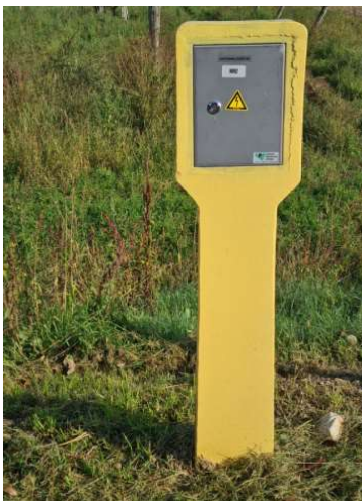
Slika 11: Prikaz postavitve stebrička katodne zaščite.
