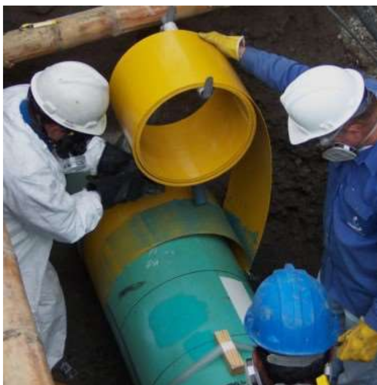
Slika 15: Prikaz izvedbe zaščite s kompozitnimi materiali (npr. ClockSpirng)[3].
